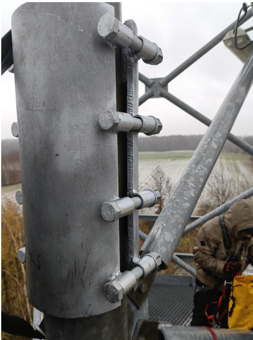
Fot. 11. Zabezpieczenie krawężnika łubkami
