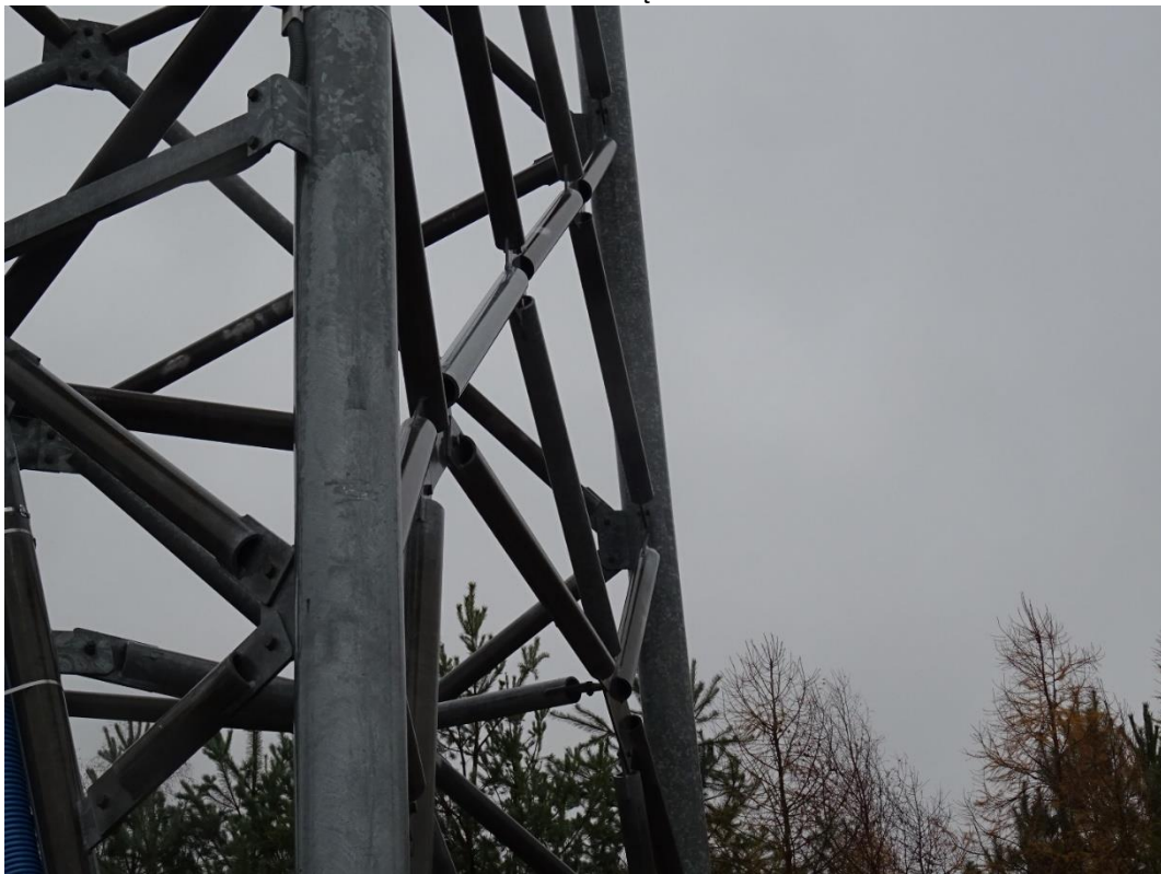
Fot. 13. Skratowanie odkształcone z płaszczyzny
