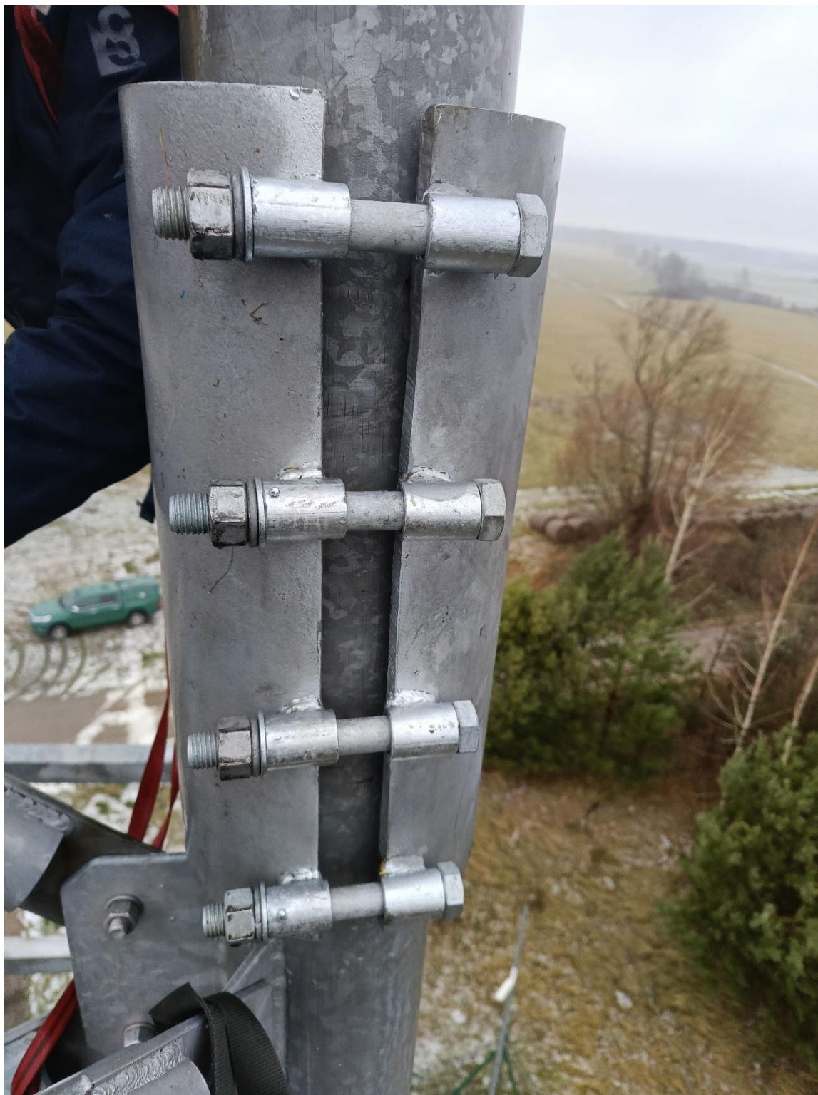
Fot. 10. Zabezpieczenie krawężnika łubkami – w trakcie montażu
