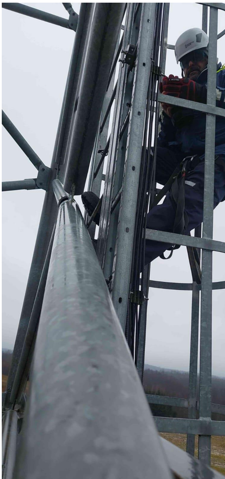
Fot. 14. Skratowanie odkształcone z płaszczyzny
