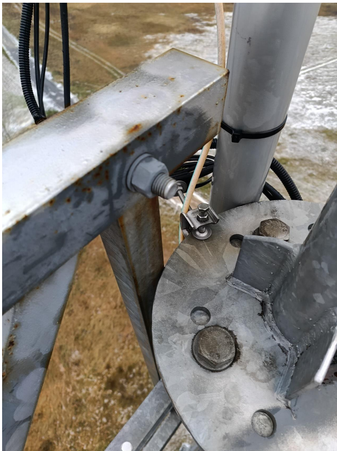
Fot. 5. Przerabiany (adaptowany) kołnierz połączenia krawężników
