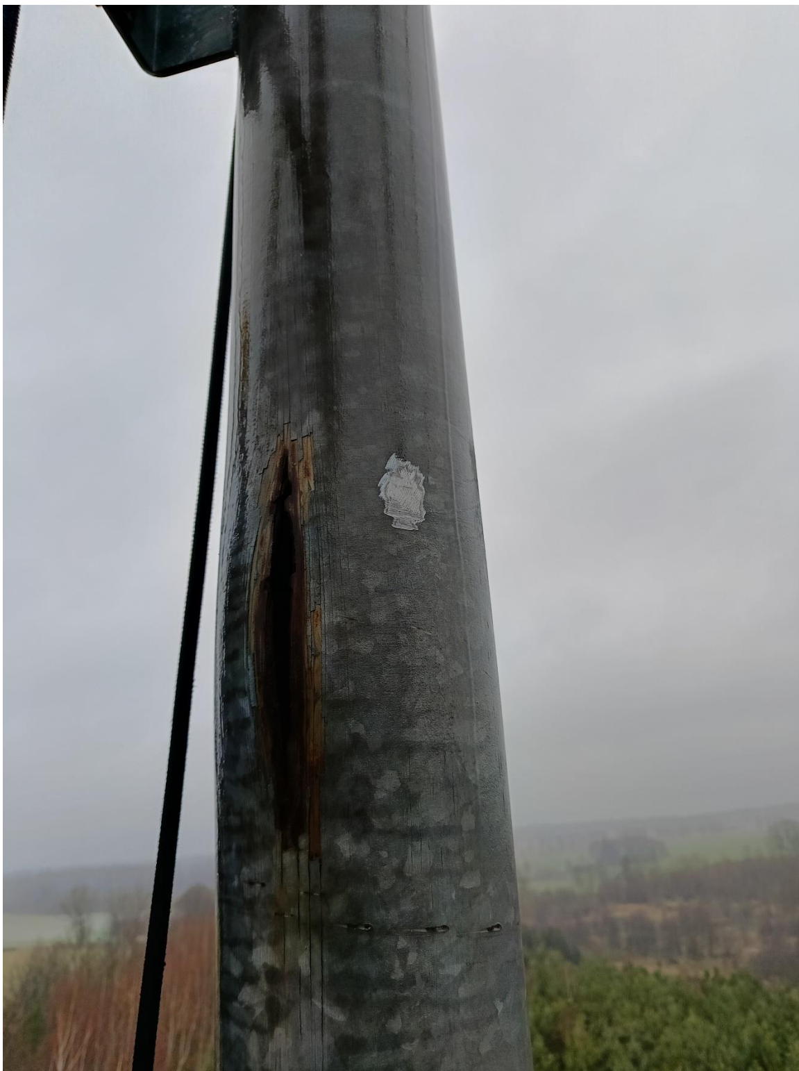
Fot. 9. Pęknięty krawężnik wieży – widoczne miejsce badań twardości
