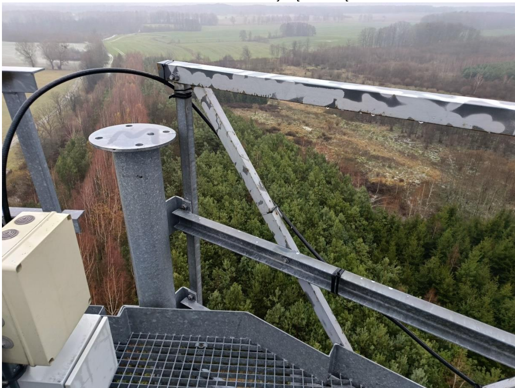
Fot. 4. Górny podest wieży
