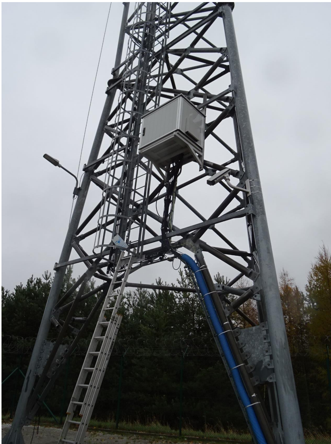
Fot. 2. Segment dolny wieży
