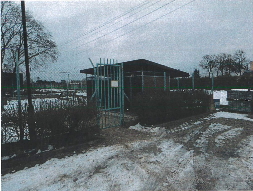
Zdjęcia terenu objętego robotami budowlanymi.
