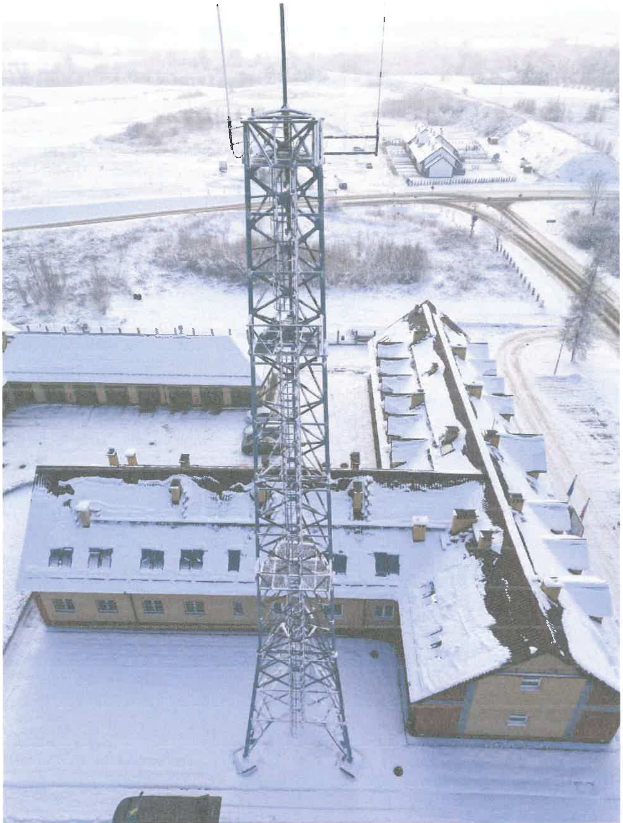
Fot. 1 Widok ogólny wieży
