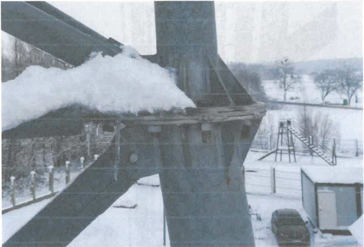
Fot. 6 Częściowo wykonane spoiny w połączeniu kołnierzym segmentów IV i V
