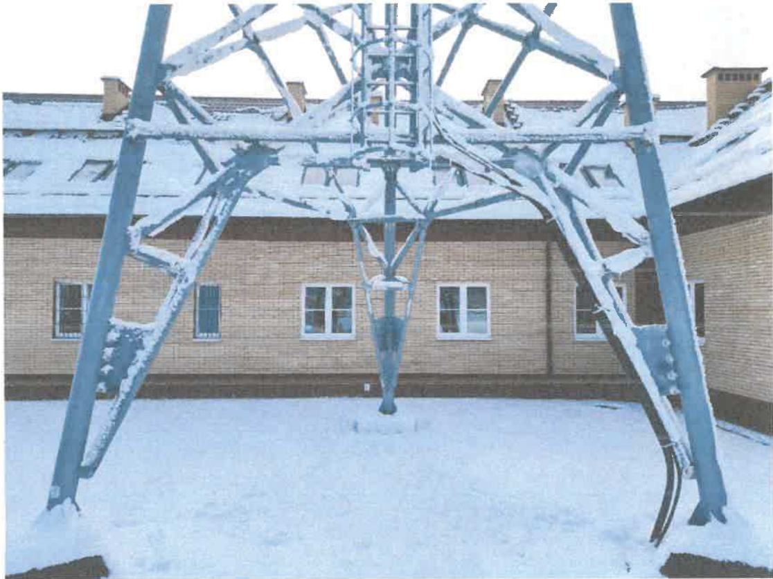
Fot. 2 Przyziemie wieży
