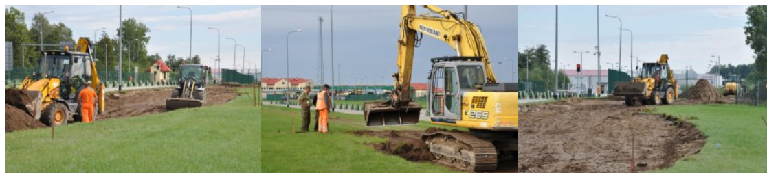
Roboty budowlane w drogowym przejściu granicznym w Grzechotkach
