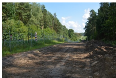
ujawnione ślady na pasie drogi granicznej
